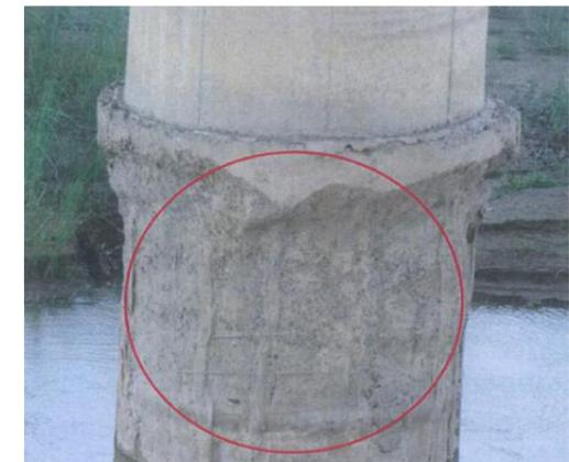
图 1.17 桩基暴露冲刷、缩颈
