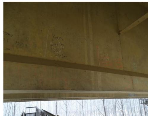
图 1.10 72-1#梁裂缝
