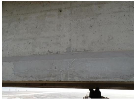
图 1.7 35-1#梁裂缝
