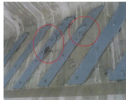
图 1.2 加固钢板表面面漆起皮脱落
