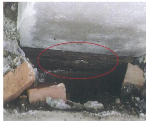
图 1.13 支座老化开裂现象
