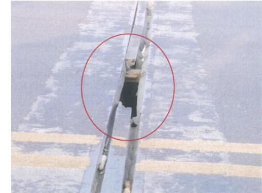
图 1.15 伸缩缝钢条断裂
