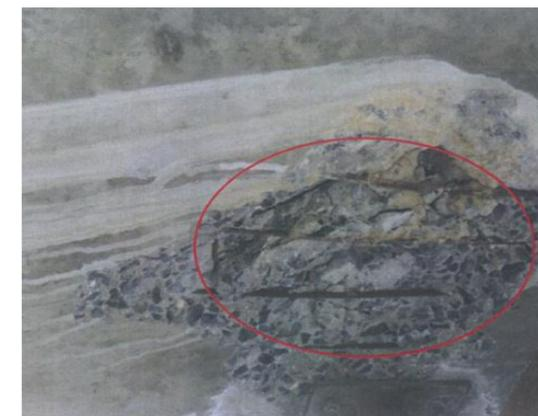
图 1.3 翼缘板底混凝土破损露筋
