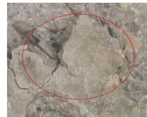
图 1.5 T 梁翼缘板板底混凝土破损露筋
