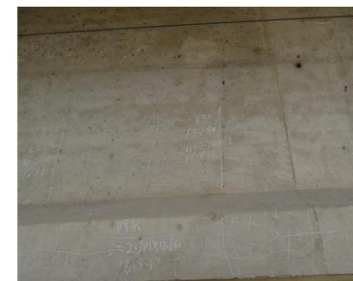
图 1.6 25-1#梁裂缝
